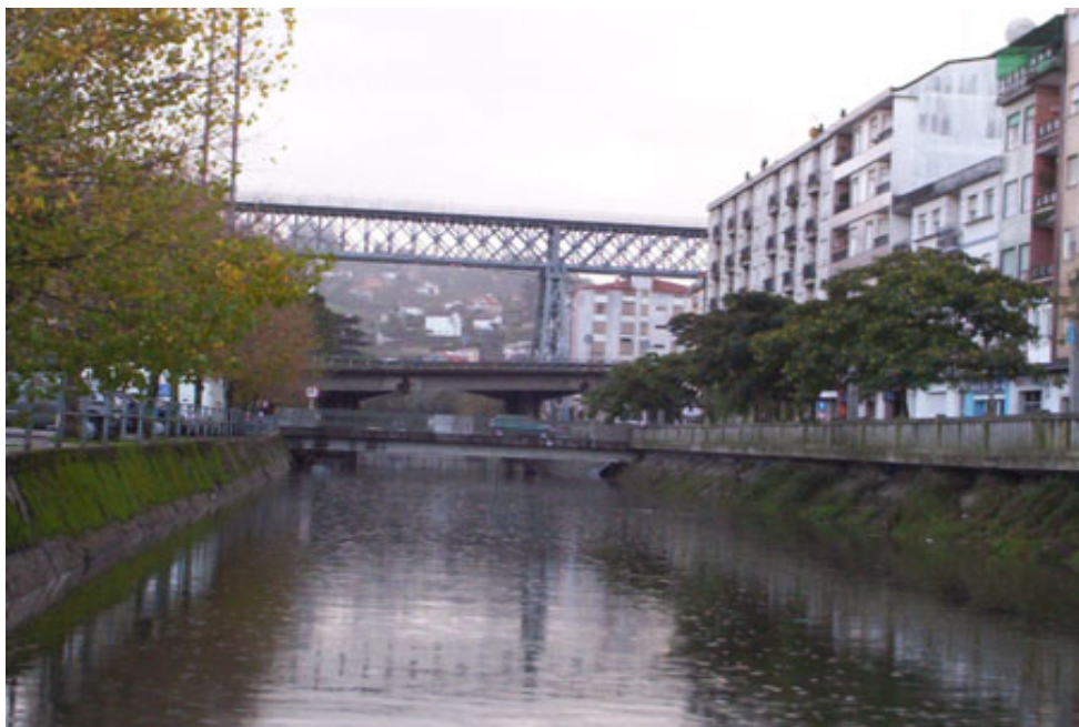
Imaxe 2. Río Alvedosa e viaduto de Pontevedra
